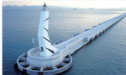
포항영일만항 남방파제 축조
